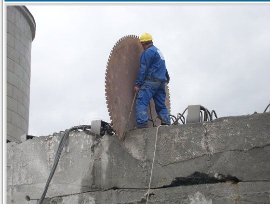
Cięcie piłą ścienną
