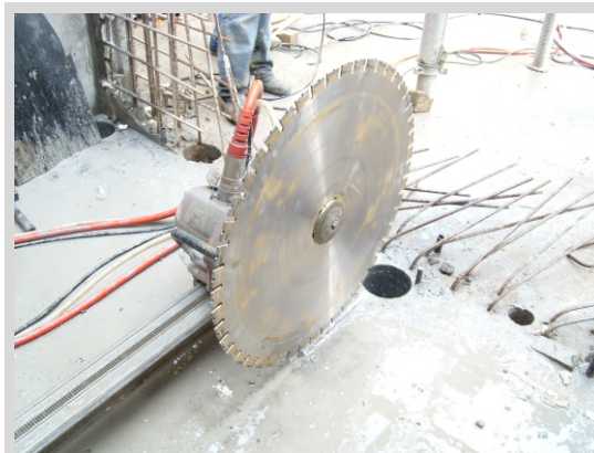
Cięcie piłą ścienną
